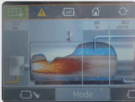
▶ 導入BOSCH 天然氣鍋爐並進行尾氣熱能回收用以加熱飼水，運轉數據可視化監控。
