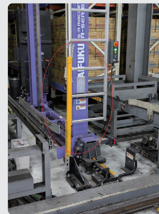
增加防護支架(扶手)。
