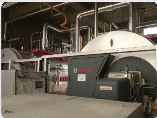
▶ 導入BOSCH 天然氣鍋爐並進行尾氣熱能回收用以加熱飼水，運轉數據可視化監控。
