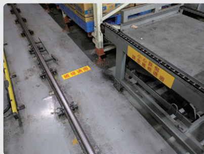
▶ 畫定維修通道及警告標示。
